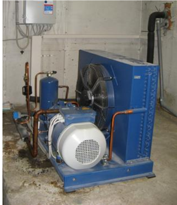
Abbildung 7: Verflüssigungssatz (Öko-Recherche 2014).
