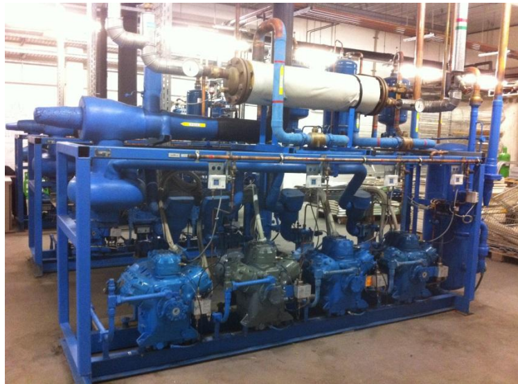
Abbildung 6: Supermarkt-Zentralanlage (Öko-Recherche 2014).
